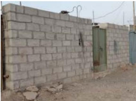
Muro de bloquetas sin columnas de confinamiento, en Olga Primitiva, Moquegua
