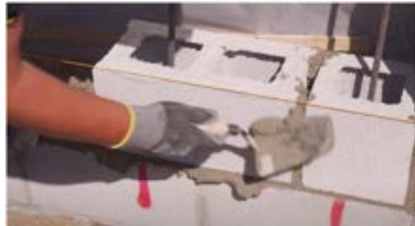
Construcción de muro con unidades de bloquetas huecas, con acero corrugado de refuerzo (Fuente: YouTube)
