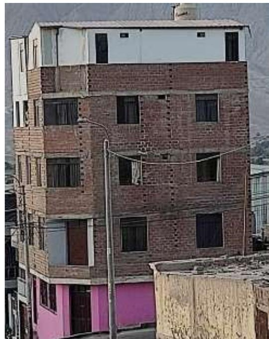
Edificación de 5 pisos, con muros sueltos (El Siglo, Moquegua)
