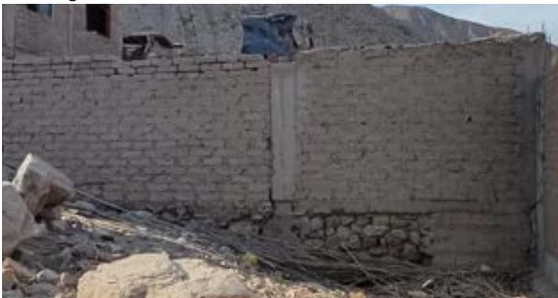
Vivienda con muro de adobe sin cimentación adecuada, ni vigas y con una columna sin amarre a los muros (Caspani, Aplao, Arequipa)
