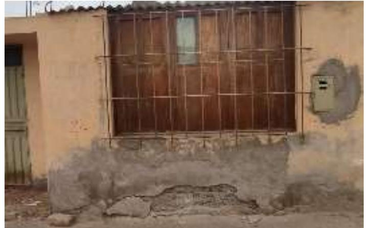
Vivienda de ladrillo con muro socavado en la parte baja e intento de resane en mal estado (Nueva Esperanza y Nueva Generación, Ilo, Moquegua)
