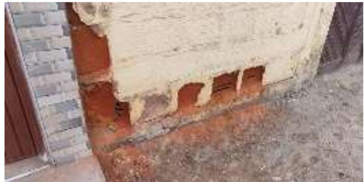
Vivienda con muros de ladrillos, socavados en la parte baja por la humedad, en La Deheza, Camaná, Arequipa
