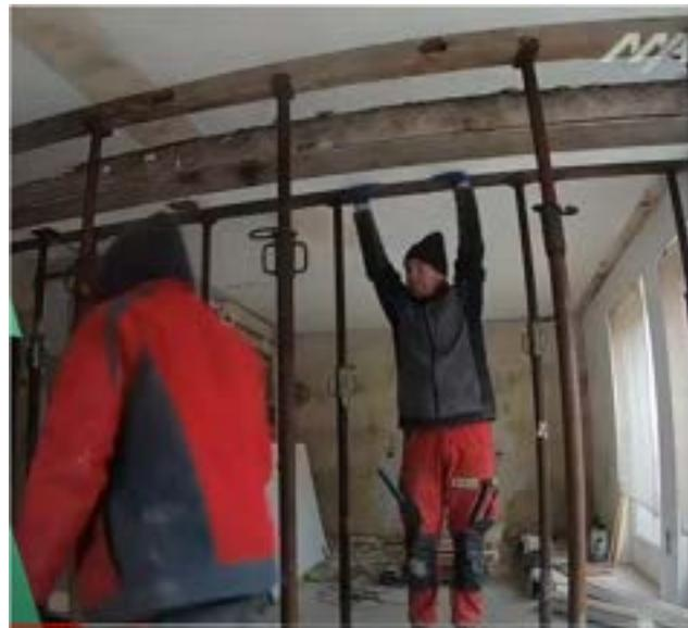
Apuntalamiento del techo a los dos costados de la viga en mal estado para poder sustituirla. (Fuente: YouTube)
