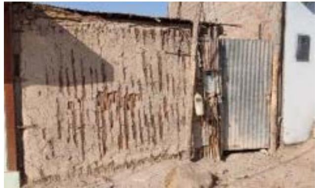
Vivienda con muros de caña y tarrajeo en mal estado de conservación. La Candelaria, Uraca, Arequipa
