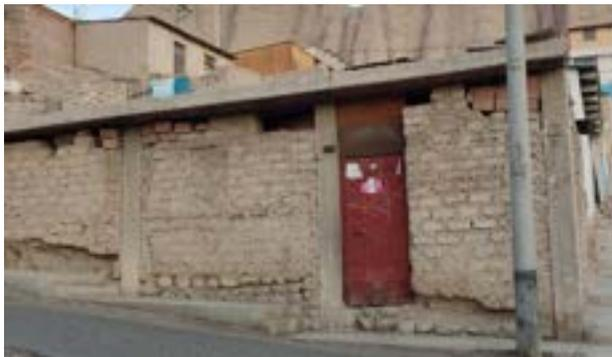
Vivienda con sistema constructivo mixto, muro de adobe y columnas y techo de concreto armado. (El Siglo, Moquegua)
